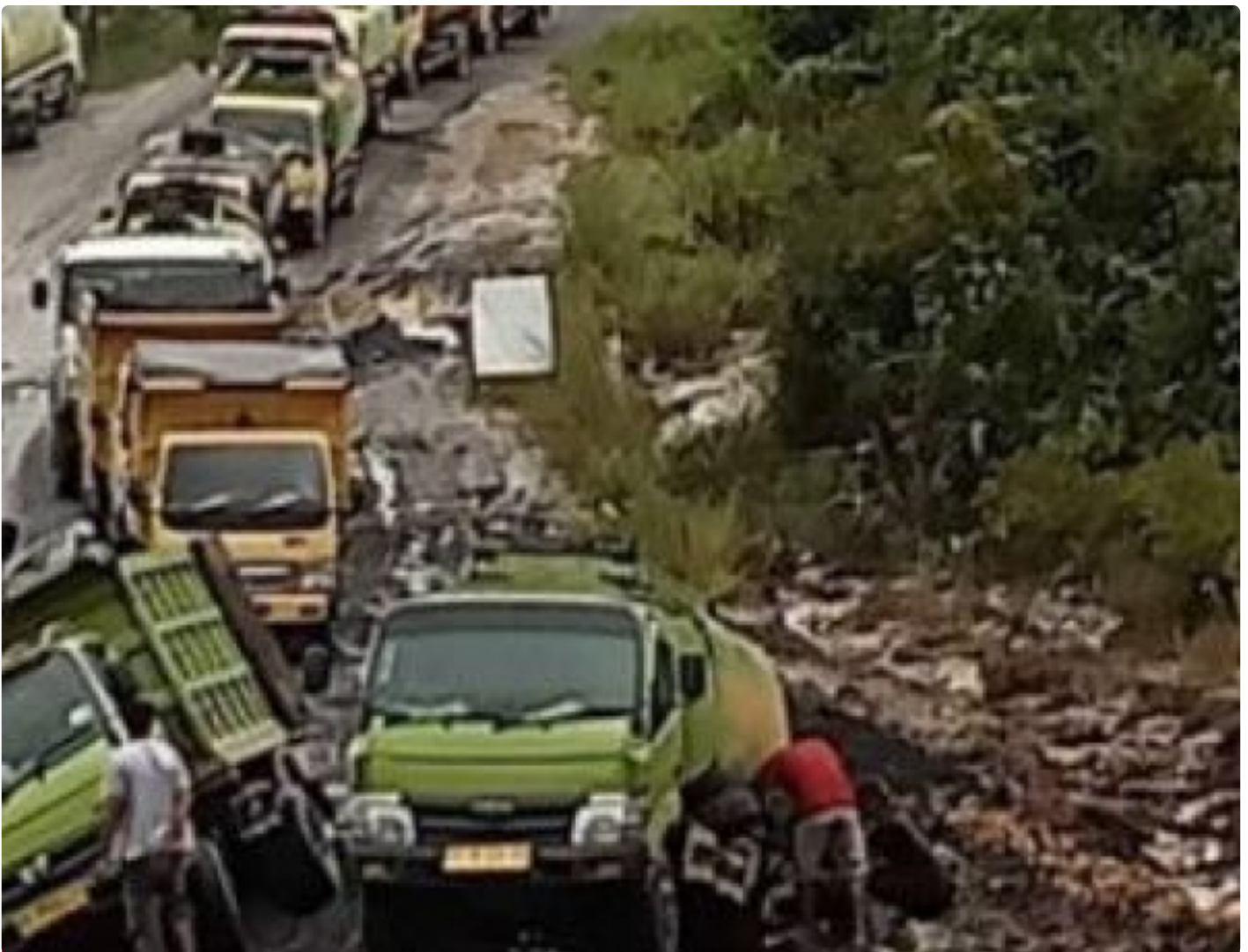
Gambar: Kondisi Ruas Jalan Palangka Raya - Kuala Kurun Beberapa Waktu lalu dengan kondisi rusak oleh angkuta PBS
